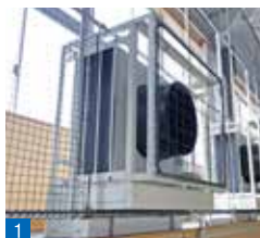
キャットウォーク上に床置き設置
