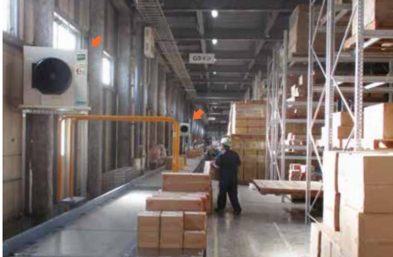
ベルトコンベア付近の作業員用に設置された「連弾」のぐっぴーバズーカ
