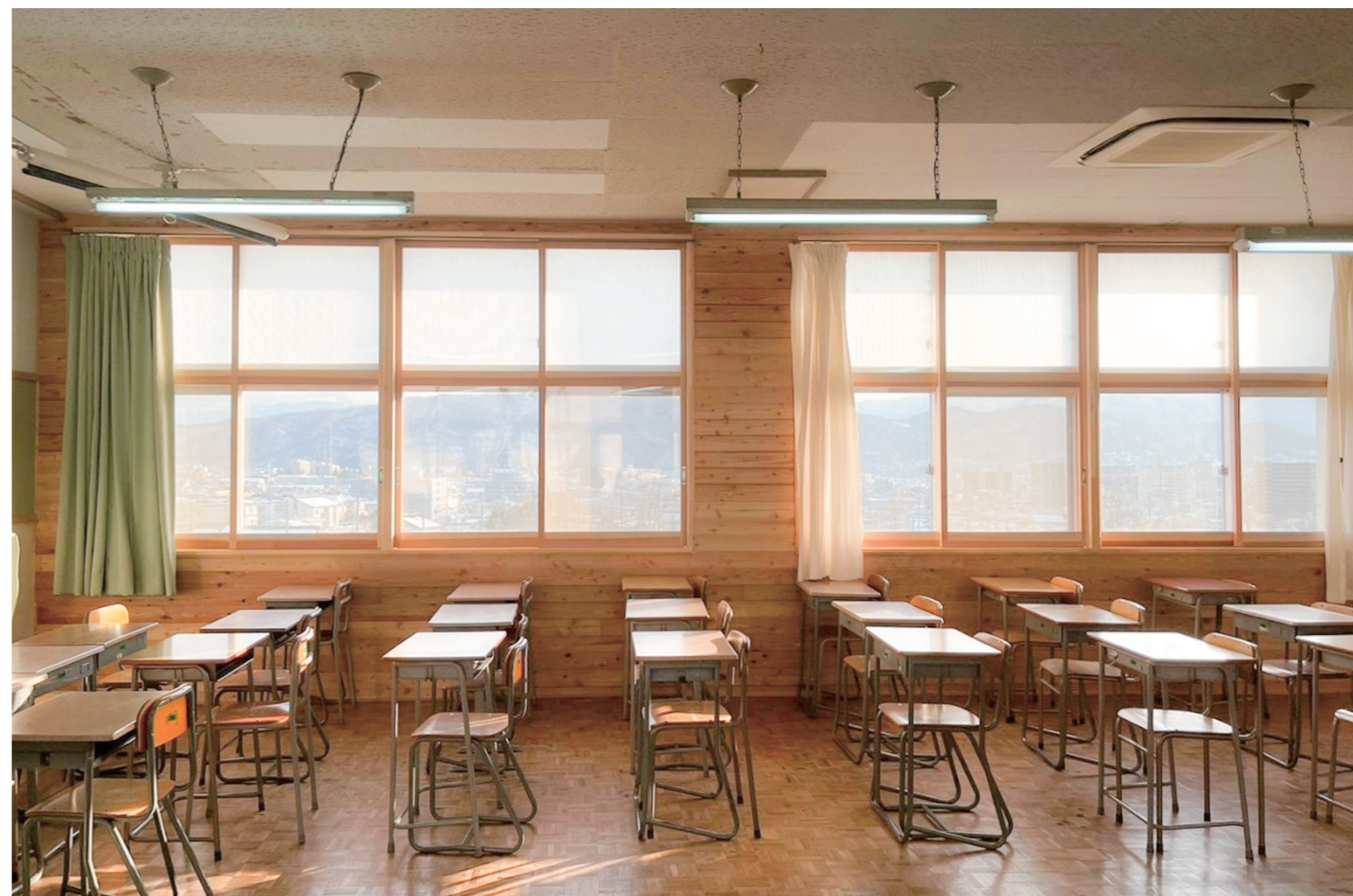
上画像は 断熱工事を実施した教室
