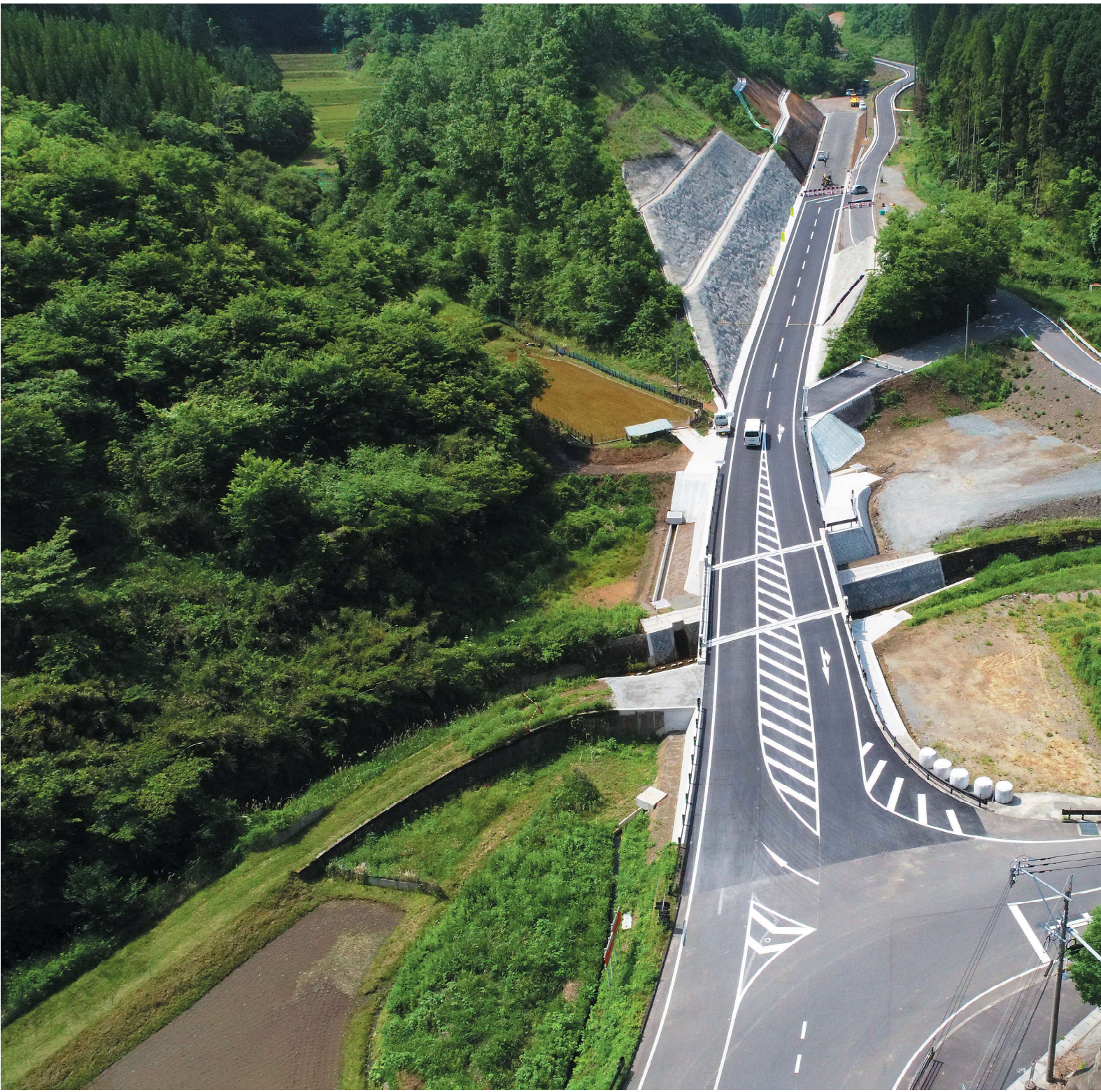
2020年6月完成 庄内久住線（竹田市直入町下田北）道路改良工事 発注者：大分県竹田土木事務所
