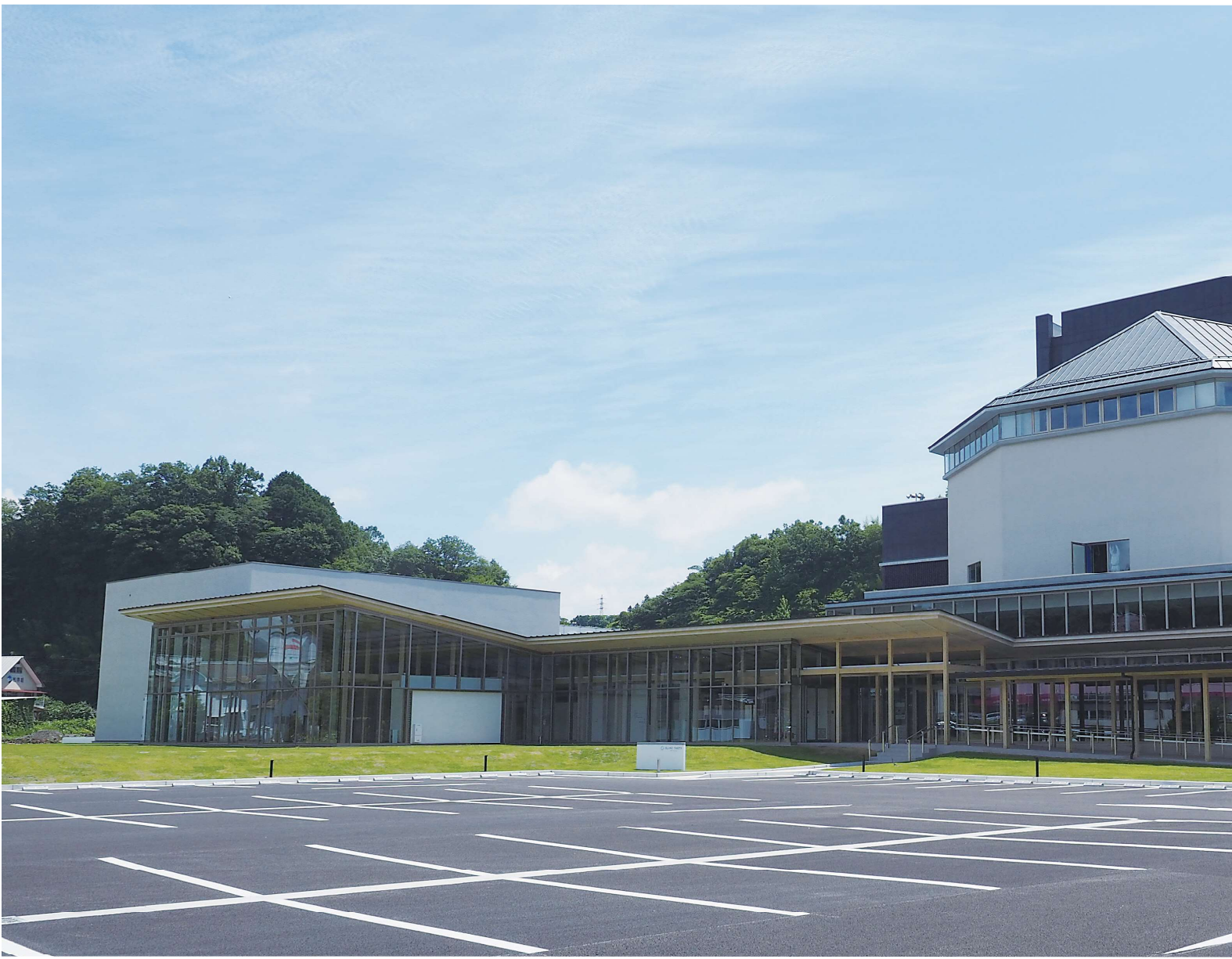
2018年5月完成 竹田市総合文化ホール グランツたけた 建設工事 発注者：竹田市
