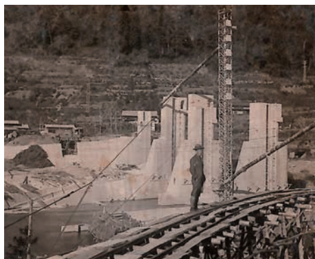
▲建設中の名倉ダム (佐藤真二さん提供)
