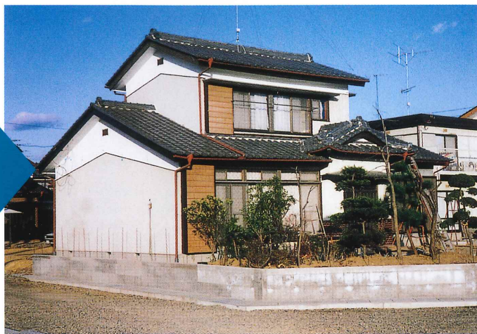
●完成（着工後約一カ月）
