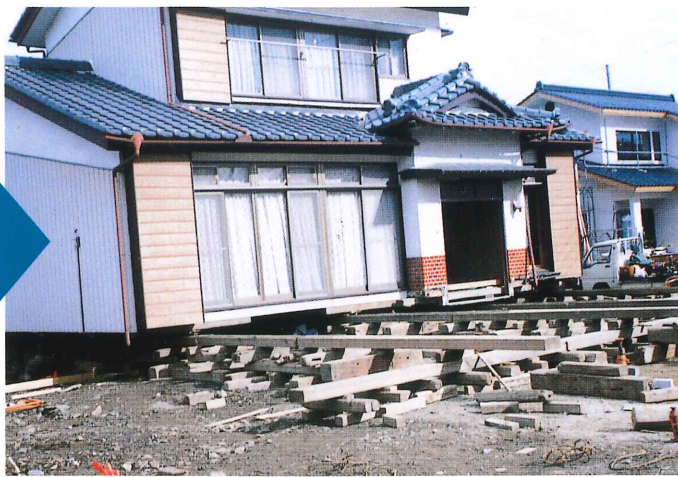
●移動中の建物
