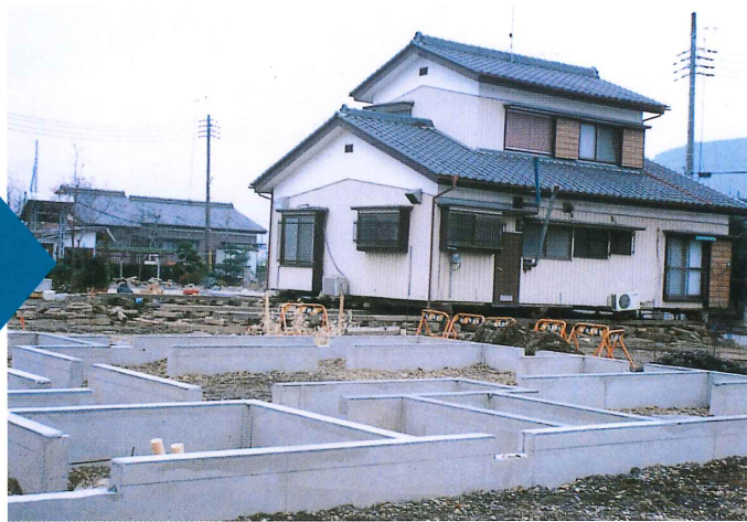
●基礎から見た移動中の建物
