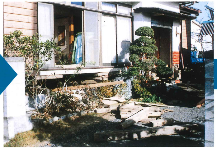
●持ち上げ工事
