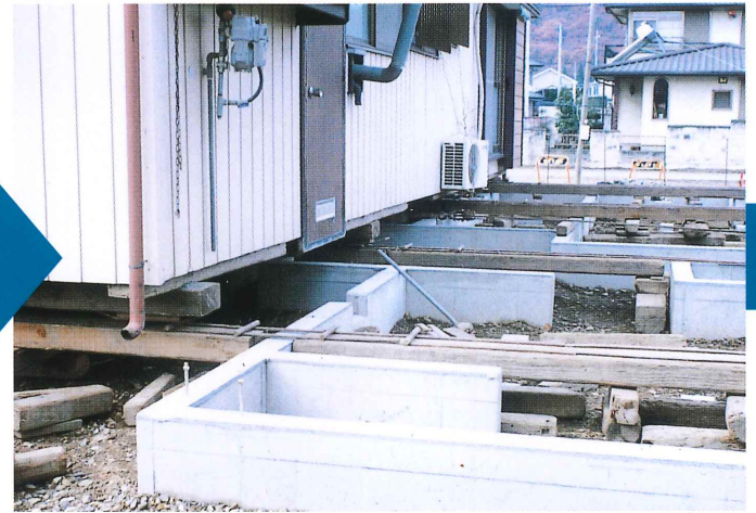
●基礎の上に建物を移動
