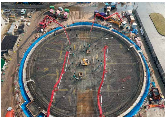
貯蔵サイロ(直径48m)底盤の施工
