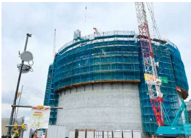
筒体はクライミングシステム工法で施工
