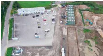
第3栄原BL※ P1掘削、P2基礎CON
