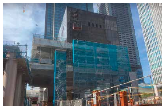
モノレール駅部を支える新設構造物
