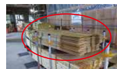
型枠支保工用敷板として廃材を利用
