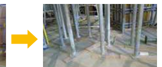
型枠支保工用敷板として廃材を利用
