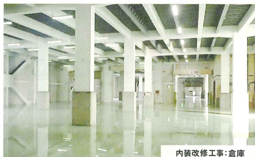
内装改修工事：倉庫
