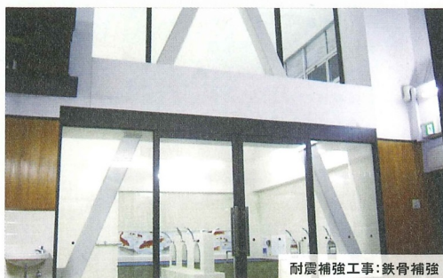
耐震補強工事：鉄骨補強
