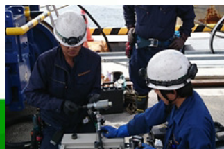
ガントリークレーン工事
