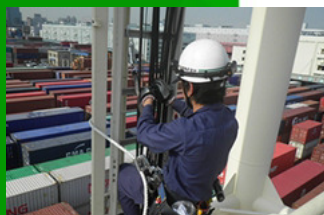
照明鉄塔の改修工事
