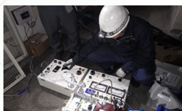
電気設備機器の耐圧試験
