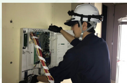
受信機取付工事
