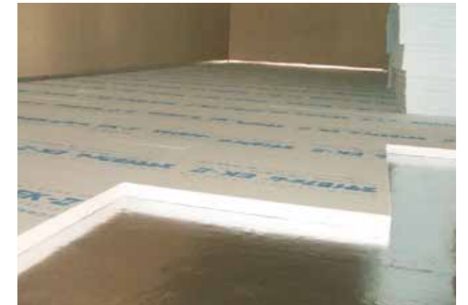
床防熱 (防湿シート+成形断熱材)
