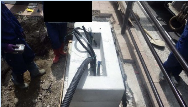
現場での設置状況
