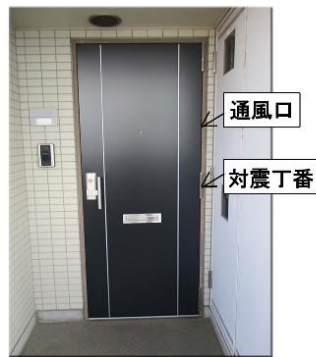
玄関ドア(通路側)
