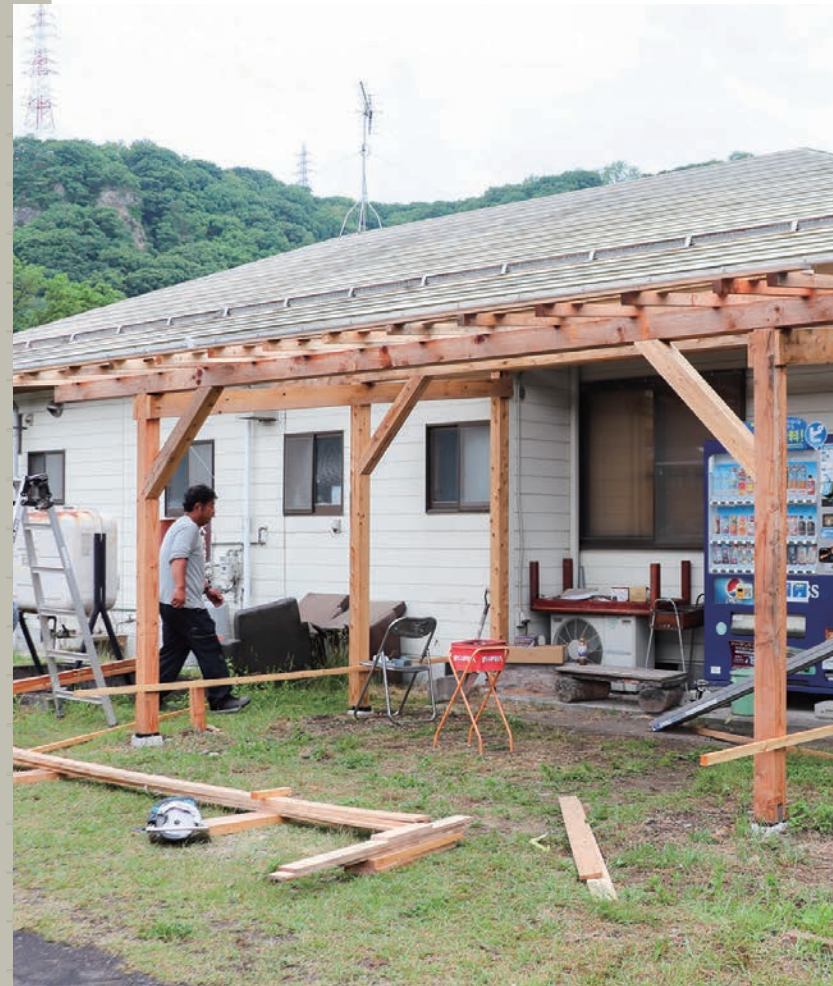
6月10日に実施した休憩所作り(自販機側)の様子
