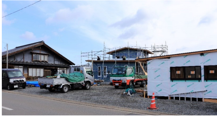
↓新築工事の現場 (2022.02.03)
