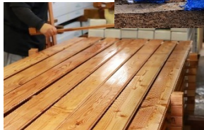
↑信州から松の床板 (建築中)
