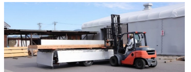
↑CLTの片面は化粧面となるので、傷や汚れが付かないようにリフトで上げる際は細心の注意が必要です。普段木材の扱いに慣れている成沢部長も「これは運びたくない！」とべそをかくほど。見ている側も心臓がドキドキしました！！
