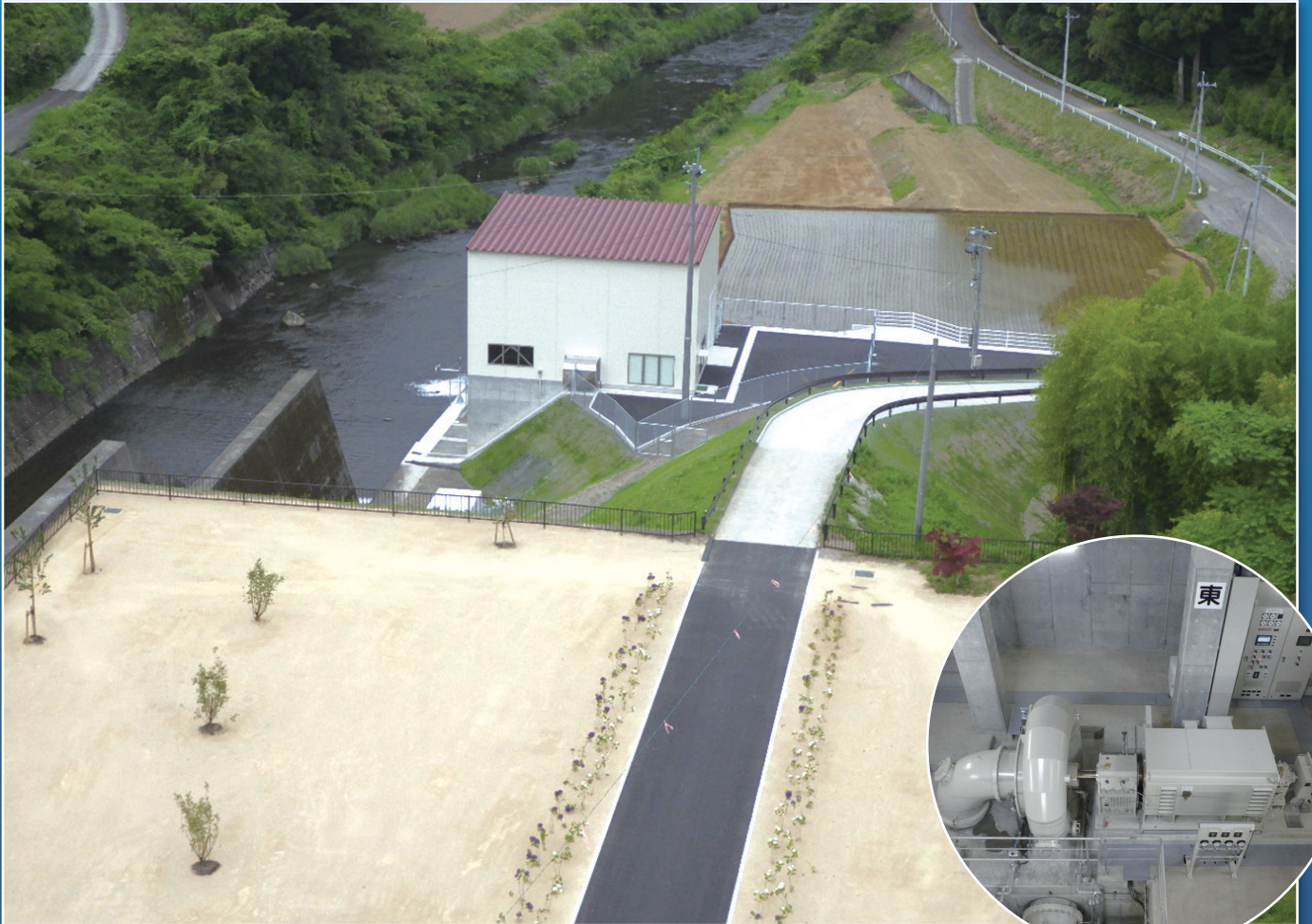
稲葉ダム小水力発電所 竹田市久住町
