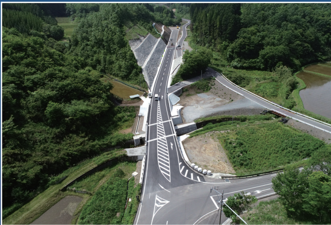
下田北 道路改良工事 竹田市直入町
