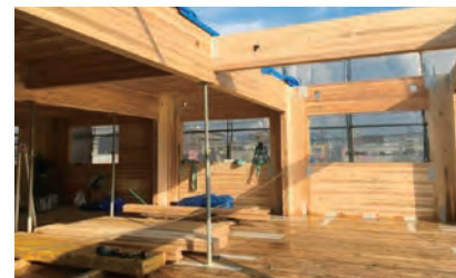
国内でもCLTを利用した建物が建設されています。写真は福岡県初のCLT工法で那珂川町に建設中の社屋。
