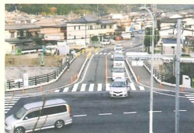
完成した内野大橋
