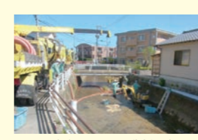
貞島川のヨシの伐採工事
