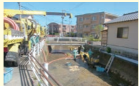
貞島川のヨシの伐採工事
