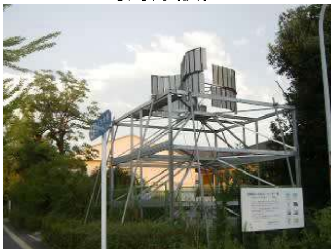
天理設置v 3段鉄骨地上5m
