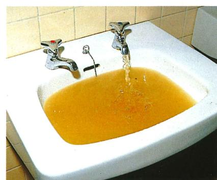
ビルの給水・給湯系で「赤水」の発生が問題になっています。給水管として使われている白ガス管の腐食が主な原因と考えられています。最近では殺菌剤として塩素を多量に使用する例が多くなり、「赤水」が発生しやすくなり、飲料不適となるケースが多くなっています。城山が取り扱う給水用薬剤は『厚生省給水用防錆薬品質企画適合品』の安心して使用できる薬品です。
