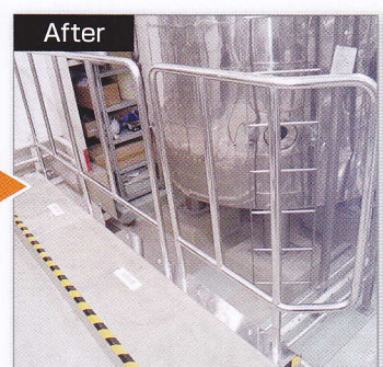
転落防止用のステンレス製手すり
