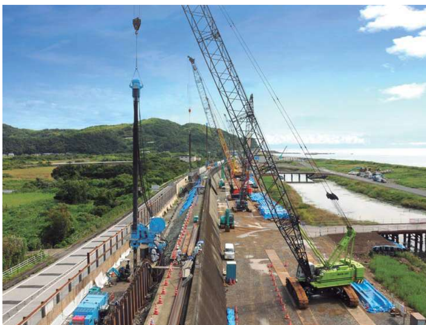
硬質地盤クリア工法による海岸堤防改良工事
