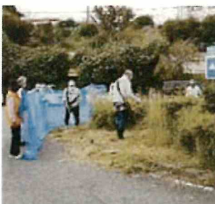
飛散防止ネットをして作業
