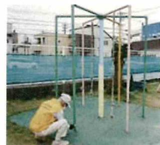
遊具の塗装作業
