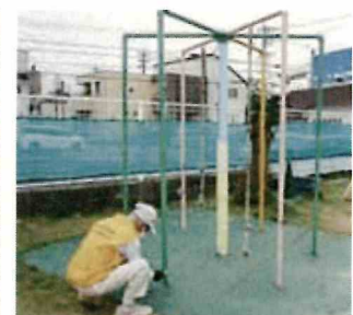
遊具の塗装作業
